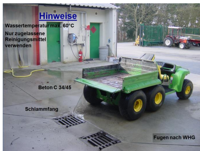
Beispiel einer Waschplatzfläche
