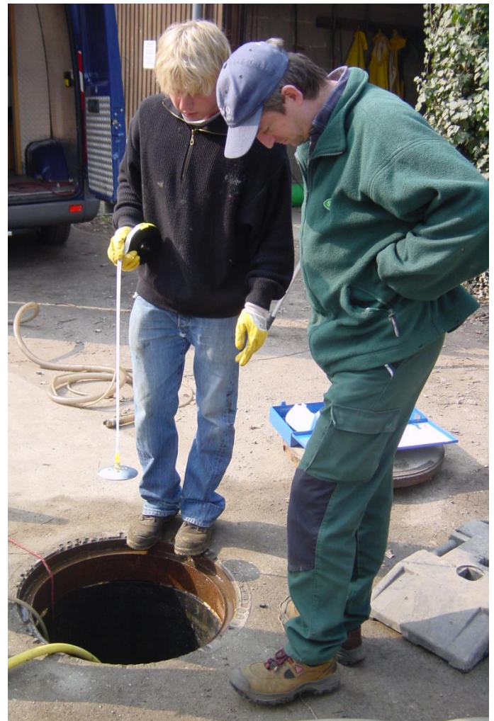
Dichtigkeitsprüfung und Schlammdickenmessung im Rahmen der Einweisung zur Eigenkontrolle. (Foto: A. Klapproth)
