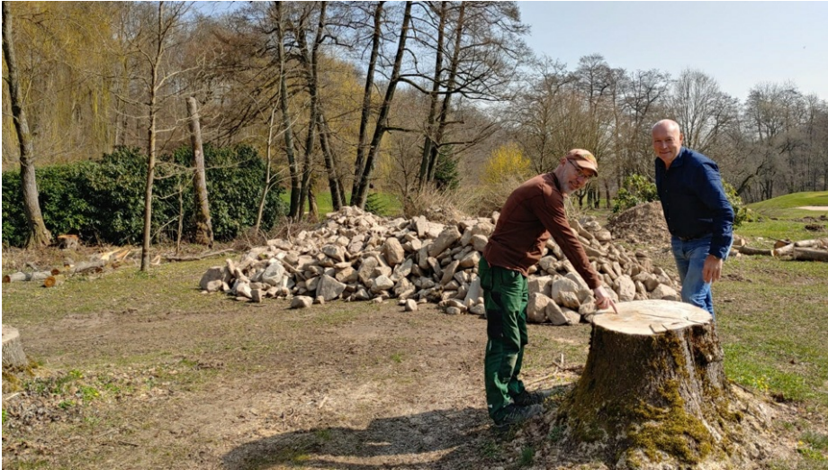
Thomas Bäder (links) und Gerald Weyer bei der Inspektion des Baufeldes für den neuen Speicherteich | © Petra Himmel
