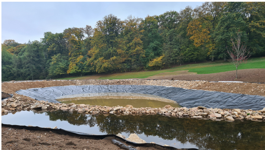
Der neue, 3600 Kubikmeter fassende Speicherteich des Wiesbadener Golf Clubs in der Entstehung. | © Wiesbadener GC
