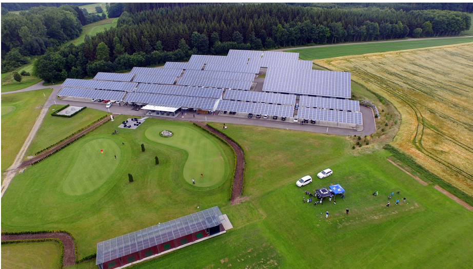
Große über dem Parkplatz aufgeständerte PV-Anlage im Golf Club Bad Saulgau. | © Drescherphoto
